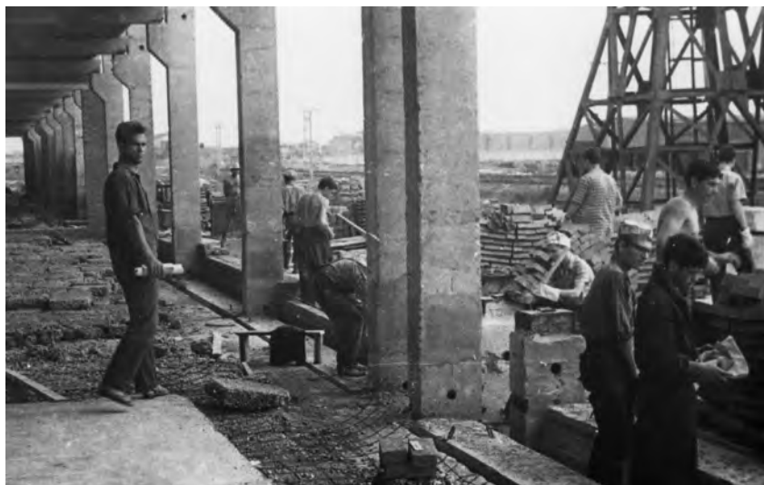
На строительстве картофелехранилища в Котляково
